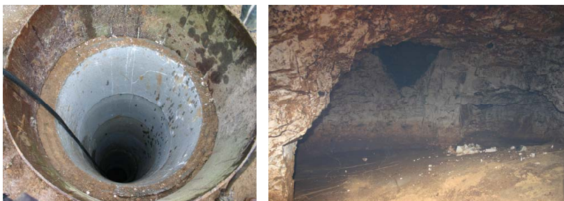
Photographies n° 11: Réalisation d'un puits et expertise d'une marnière
