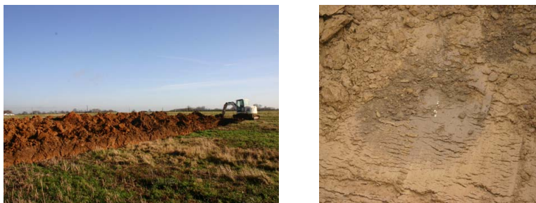
Photographies n° 9: Découverte d'un puits de marnière lors d'un décapage
