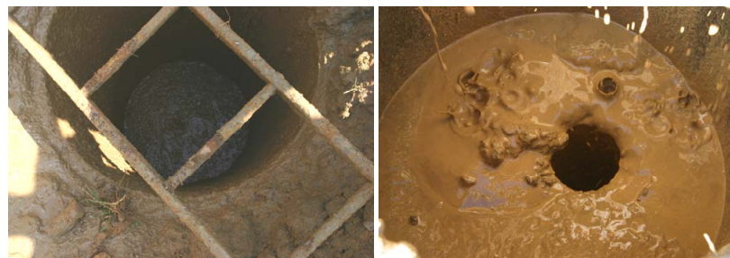
Photographies n° 12: Remblaiement d'une marnière
