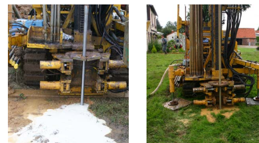
Photographies n° 10: Exemple de forages
