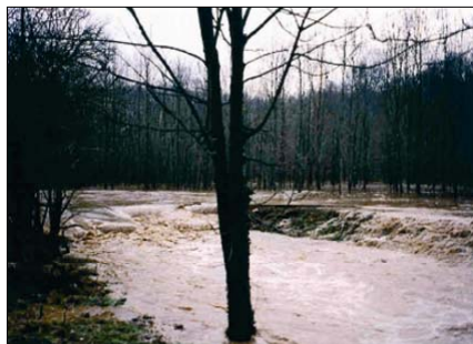
Au droit du répartiteur du bassin de rétention
