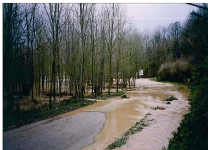
A l'aval de la voie ferrée
