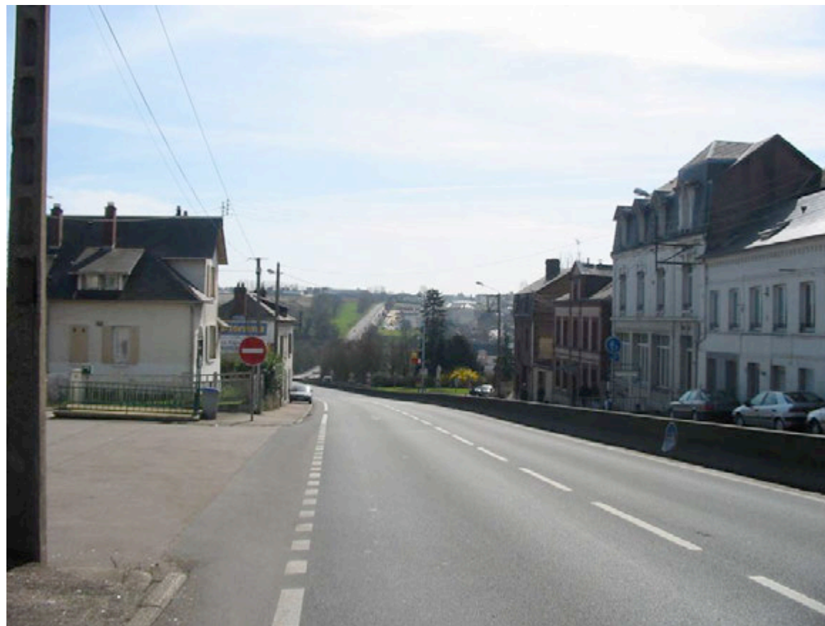
La RD 6015 au niveau de la gare SNCF, dans sa section à 2 voies vers Yvetot et 1 voie vers Rouen.
